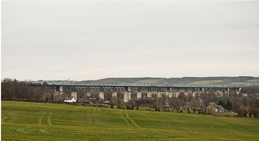
Göhlviadukt bei Moresnet
