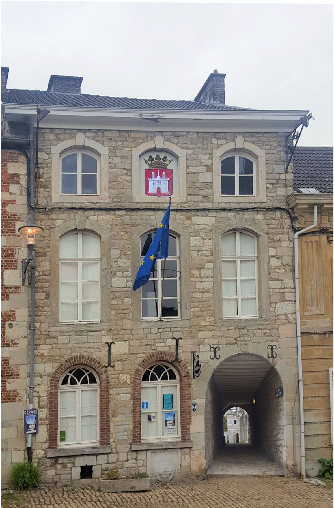
Hier hatte der hohe Gerichtshof zu Limburg seinen Sitz, der u. a. bei den Bockreiterprozessen in Herzogenrath die Folter zu genehmigen hatte
