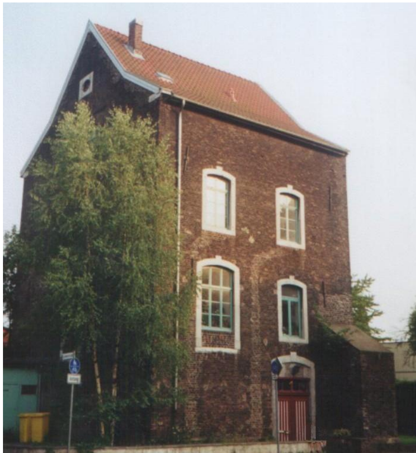
Das alte Pumpenhaus in Eschweiler Pumpe-Stich
