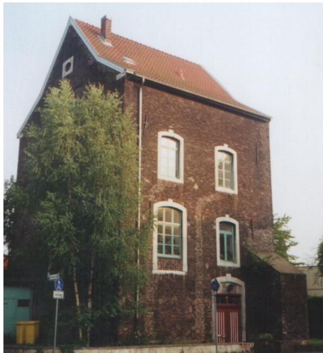
Das alte Pumpenhaus in Eschweiler Pumpe-Stich
